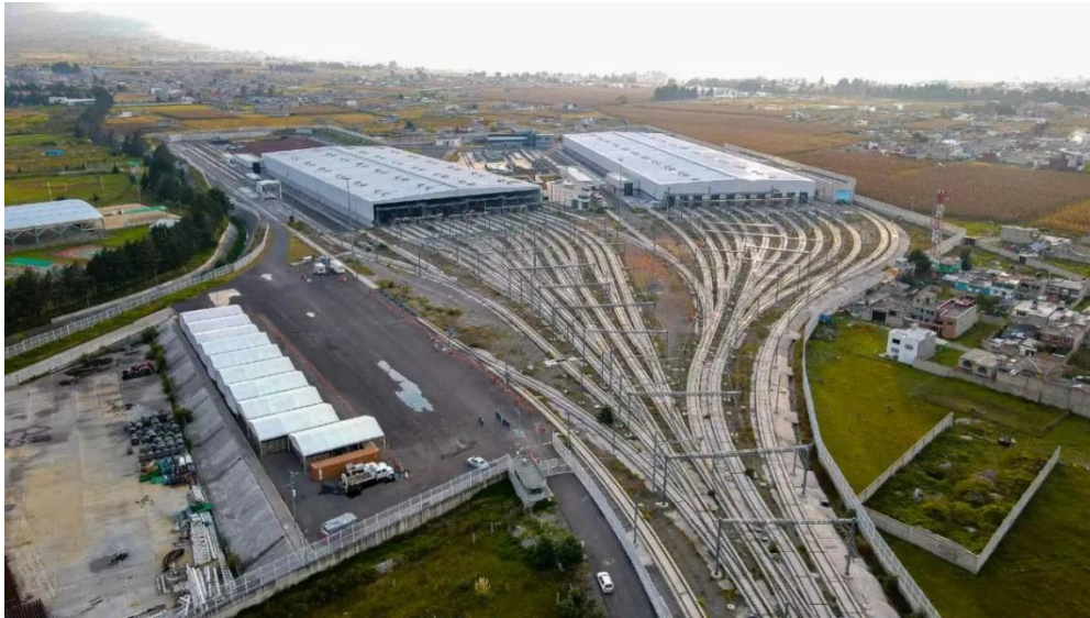
Talleres de mantenimiento, patios y cocheras del tren interurbano localizados a solo un kilómetro de la estación terminal Zinacantepec, Estado de México.
